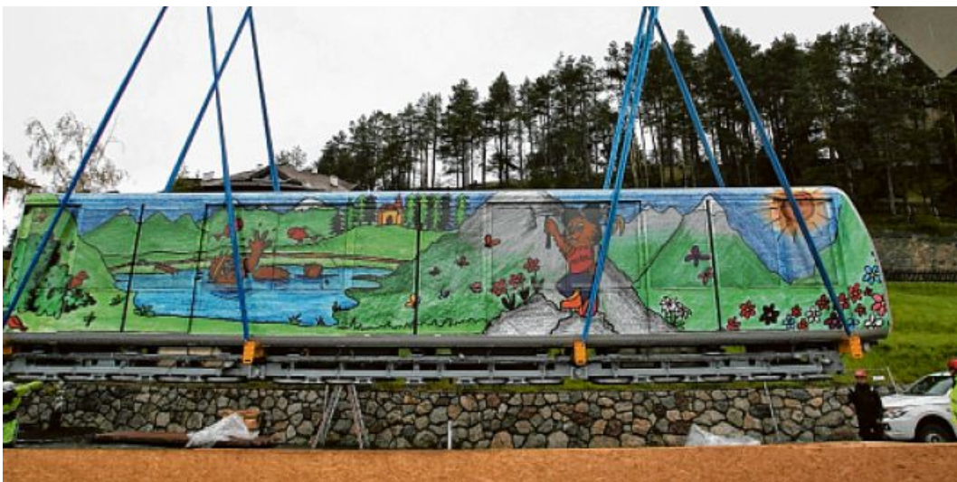
Mit Hilfe eines Krans wurde die erste der drei neuen Kabinen in den Tunnel der U-Bahn eingehoben. Fotos: Zangerl
